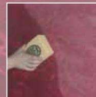
6. Im Anschluss wird das PANDOMO® SL Steinöl dünn aufgetragen und überschüssiges Öl mit einem fusselfreien Lappen abgerieben.
