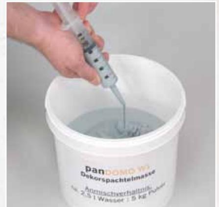
2. Die Farbmenge aus der Spritze wird dem gesamten Anmachwasser zugefügt.
