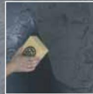
5. Im Anschluss wird das PANDOMO® SL Steinöl dünn aufgetragen und überschüssiges Öl mit einem fusselfreien Lappen abgerieben.
